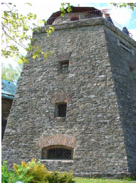
Fot. 7.2 Wapiennik po pracach adaptacyjnych w 1978r.
