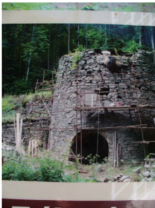
Fot. 7.11 Wapiennik w trakcie odbudowy
