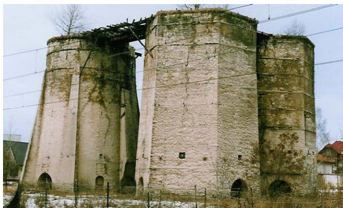
Fot. 5.20 Widok ogólny od strony południowo – zachodniej
