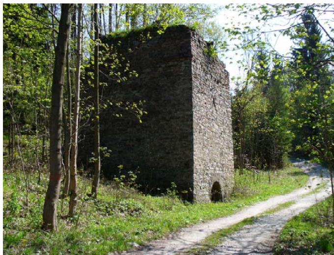
Fot. 7.12 Opuszczony wapiennik w Jesennikach
