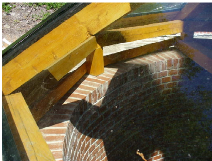
Fot. 7.15 Modernizacja korony wapiennika i komory wypalania
