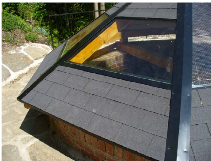
Fot. 7.16 Modernizacja korony wapiennika i komory spalania
