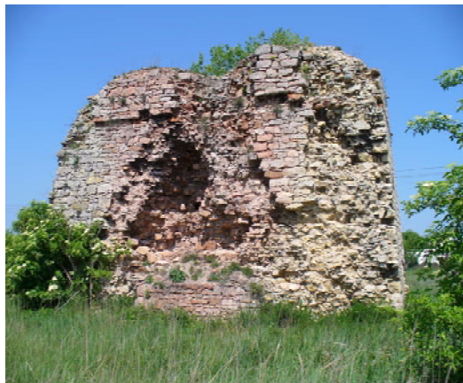
Fot. 1.21 Pozostałości wapiennika w Kamieniu Śląskim
