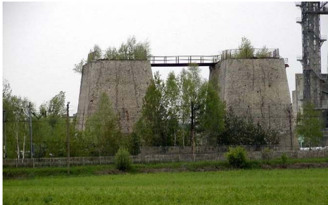
Fot. 1.7a Wyłączona z eksploatacji w latach 80 XX w. bateria wapienników w Górażdżach
