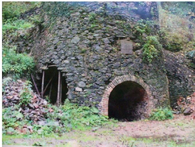
Fot. 7.10 Wapienník w Jawornikach – przed pracami konserwatorskimi
