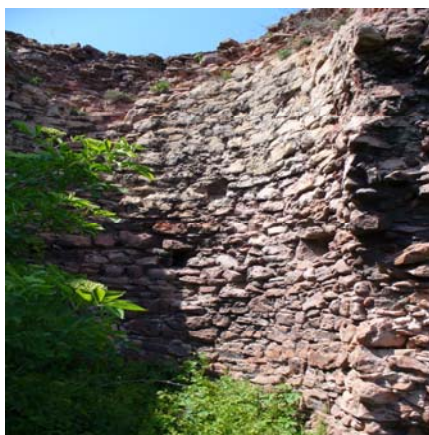
Fot. 1.30 Pozostałości wapiennika w Kamieniu Śląskim
