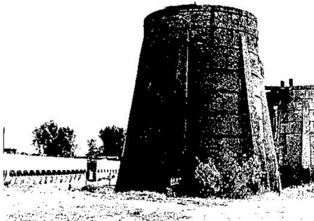
Fot. 5.5 Piec nr 1. Widok od strony północno-zachodniej
