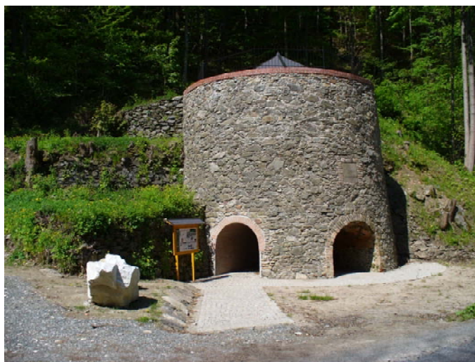
Fot. 8.2 Wapiennik po odbudowie
