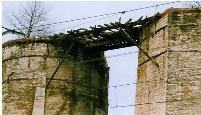
Fot. 5.21 Piec nr 5, 6. Widok kładki obsługowej wraz ze zwieńczeniami pieców
