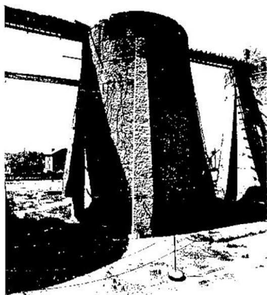
Fot. 5.6 Piec nr 2. Widok od strony zachodniej
