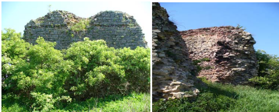
Fot. 1.22 Zniszczony piec wapienniczny w Kamieniu Śląskim oraz jego wnętrze
